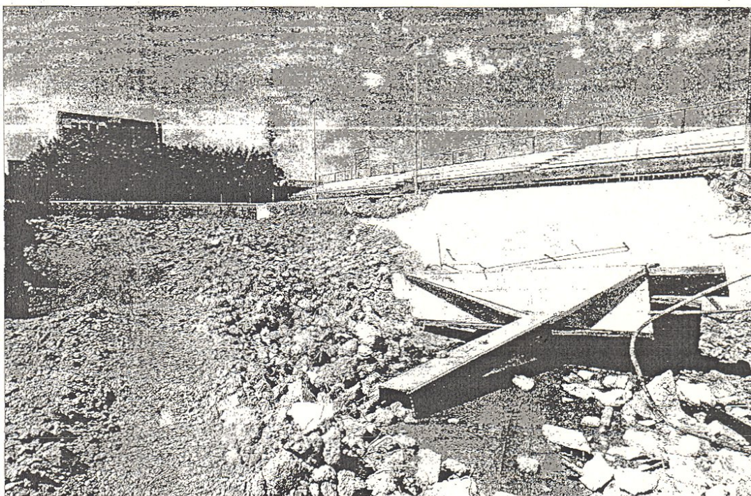
■ Estat actual de les obres del complex d'aigües. La piscina descoberta de les instal·lacions de l'Estadi es troba gairebé enderrocada. FOTO: JOAN REVILLAS
