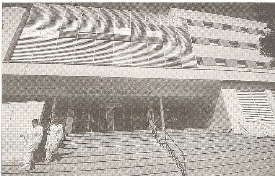
Imatge de les instal·lacions de l'Hospital Verge de la Cinta de Tortosa, a la comarca del Baix Ebre. FOTO: JOAN REVILLAS
