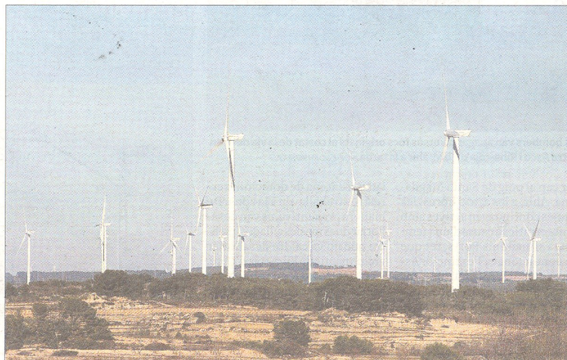
Imatge de la implantació eòlica actual a l'altiplà de la Terra Alta. FOTO: JOAN REVILLAS
