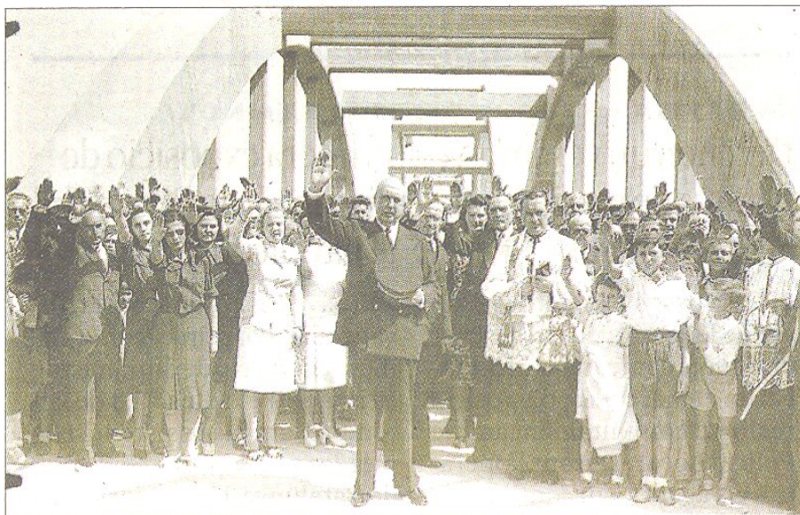
Imatge del dia de la inauguració del pont d'Arcades, el 7 de setembre de 1943. FOTO: ARXIU COMARCAL DE LA RIBERA D'EBRE. REGISTRE 8. AUTOR: JOSEP LLOBERAS ROCA
