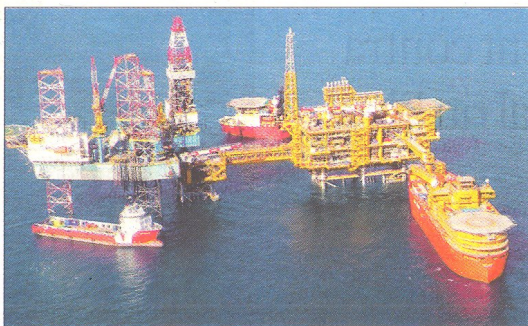
La plataforma marina del Castor. FOTO: ESCAL UGS
