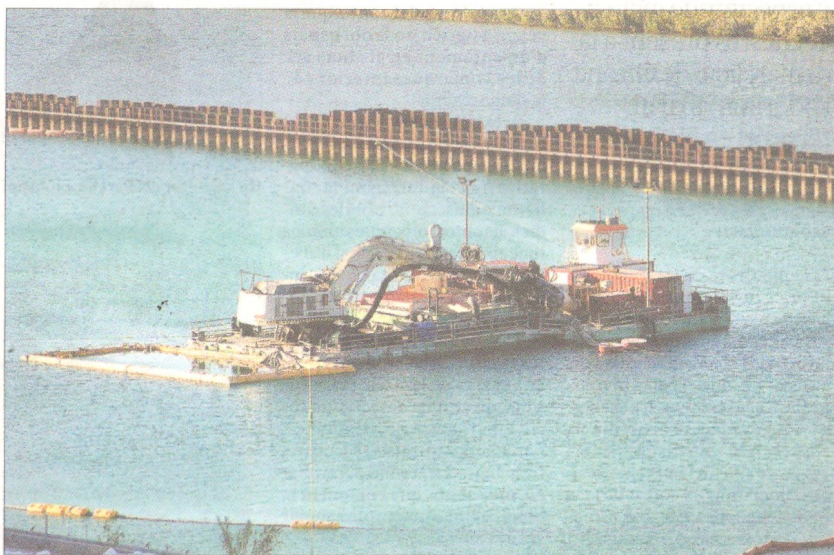
La draga extraient llocs contaminats, ahir a la tarda al pantà de Flix. FOTO: JOAN REVILLAS
