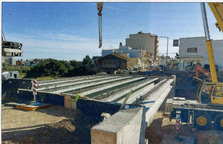
Este dimecres se van instal·lar les noves bigues del pont dels Sequesos. / CEDIDA
