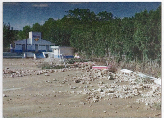
Imatge de l'estat en què va quedar el camp de futbol. / CANAL TE
