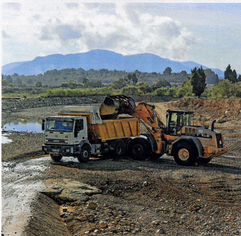
Treballs en marxa al barranc de la Galera, al terme municipal de Masdenverge. FOTO: J. REVILLAS
