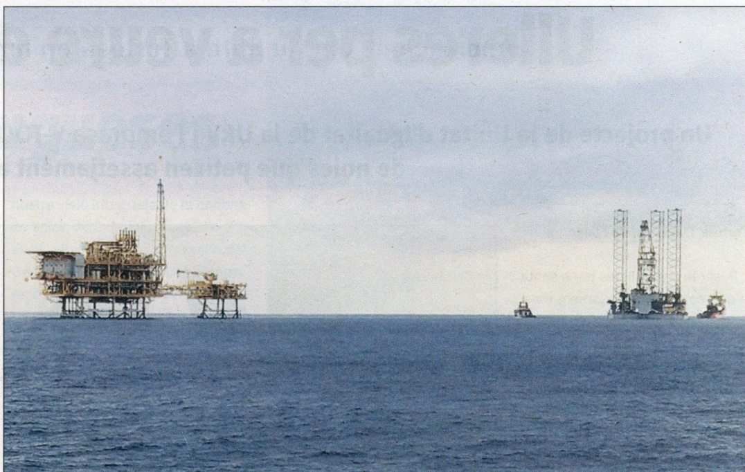
Els treballs de segellament del magatzem de gas s'han dut a terme amb una plataforma marina flotant. / ENAGÁS
