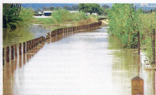
La nova Via Verda a Amposta, totalment inundada. FOTO: J. REVILLAS
