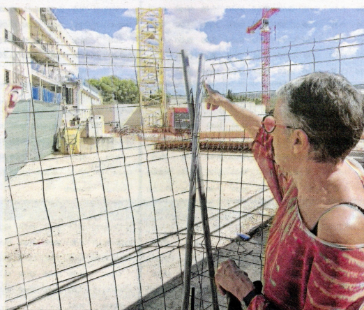
La consellera Olga Pané visitant les obres d'ampliació de l'actual Hospital Verge de la Cinta, ahir al migdia. FOTO: J. REVILLAS
