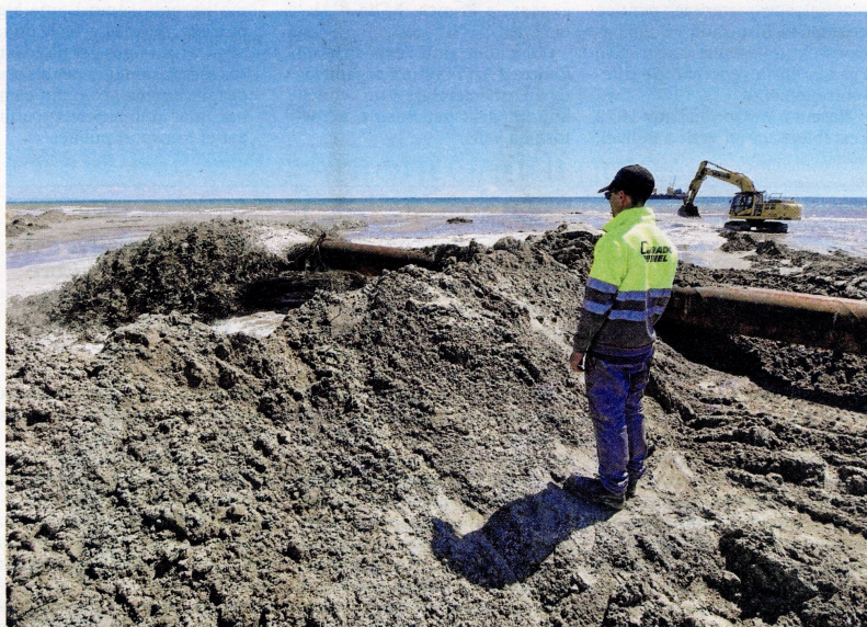
Última actuació per protegir Buda, amb arena procedent del Port de Tarragona. FOTO: JOAN REVILLAS
