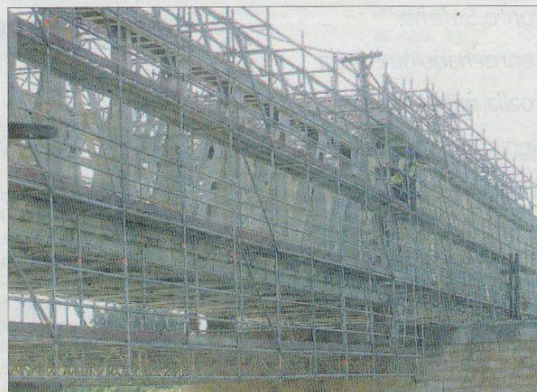
► Una gran bastida cobreix actualment bona part de l'antic pont del ferrocarril. FOTO: JOAN REVILLAS
