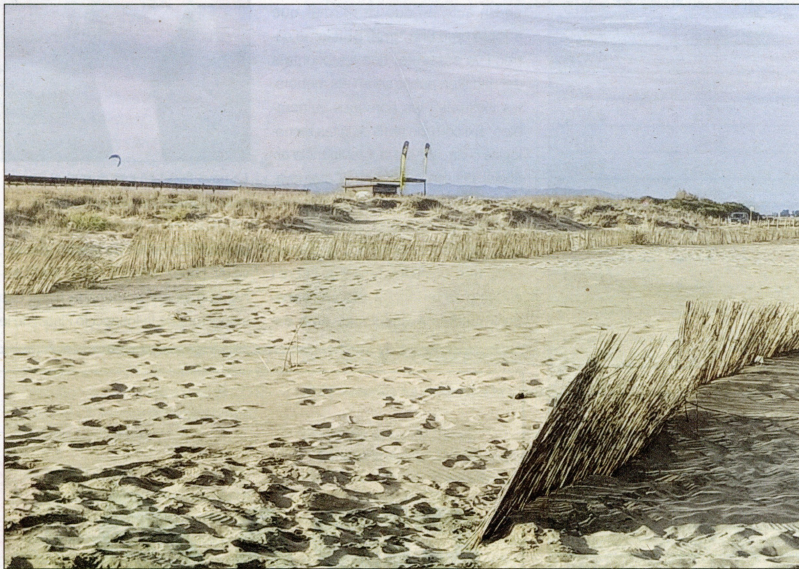
Imatge recent dels retenidors d'arena habilitats a la platja del Trabucador que dona a mar obert. / Ò.M.J.
