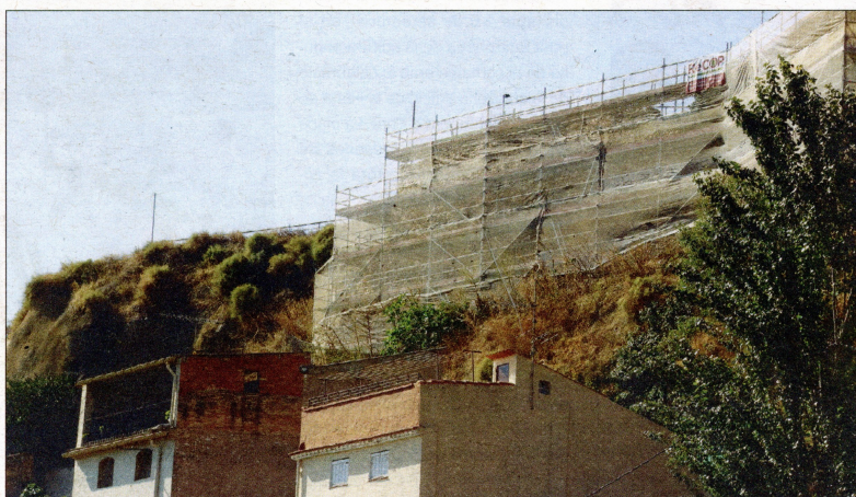
Les balisses de les obres, ja instal·lades a les muralles del castell.
