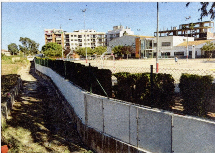
Una de les obres a la Ràpita per a facilitar el desguàs en cas de molta pluja.
