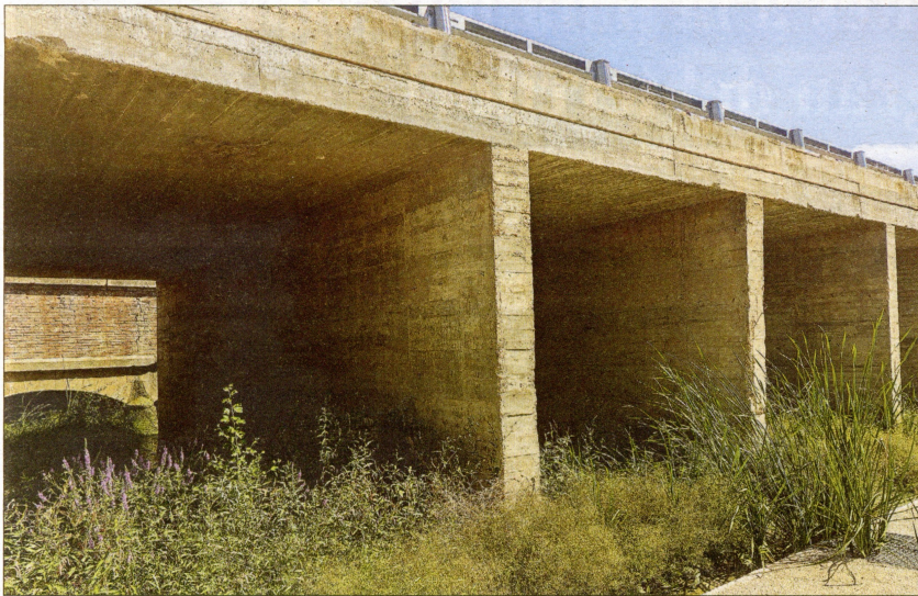
Calaixos ampliat sota la carretera per a facilitar la desembocadura del barranc, però que topen amb ulls de desaigüe molt menuts sota la plataforma del canal, com s'aprecia al fons. / ÒSCAR MESEGUER
