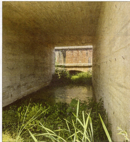
Calaixos ampliat sota la carretera per a facilitar la desembocadura del barranc, però que topen amb ulls de desaigüe molt menuts sota la plataforma del canal, com s'aprecia al fons. / ÒSCAR MESEGUER
