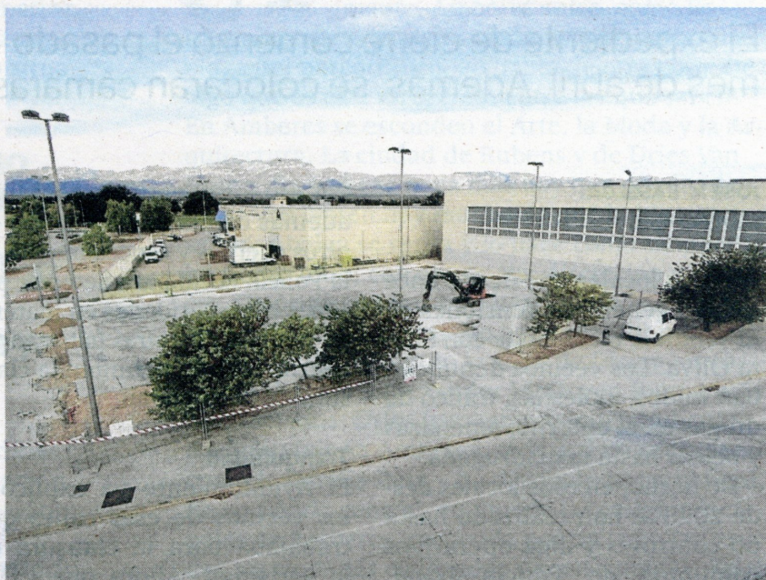
Maquinària treballant a la pista, ahir al matí. FOTO: J. REVILLAS
