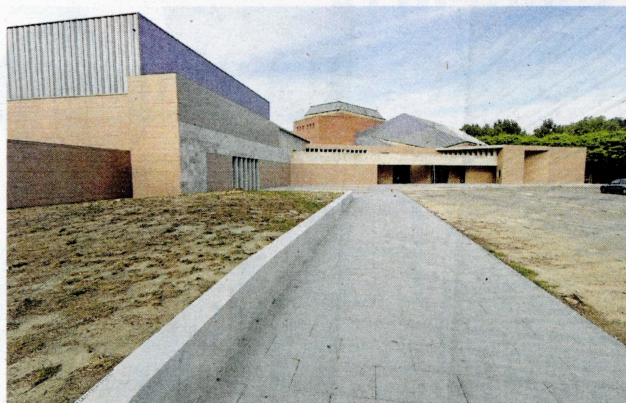
Exterior de la nova façana de l'Auditori Felip Pedrell de Tortosa, ahir.
