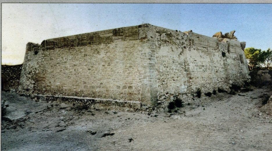
ABANS I DESPRÉS DE LA INTERVENCIÓ. Les actuacions de consolidació estructural han permès frenar el deteriorament de l'estructura i reconstruir les parts dels parapets que havien patit afonaments. /JOAN JOSEP CAROT
