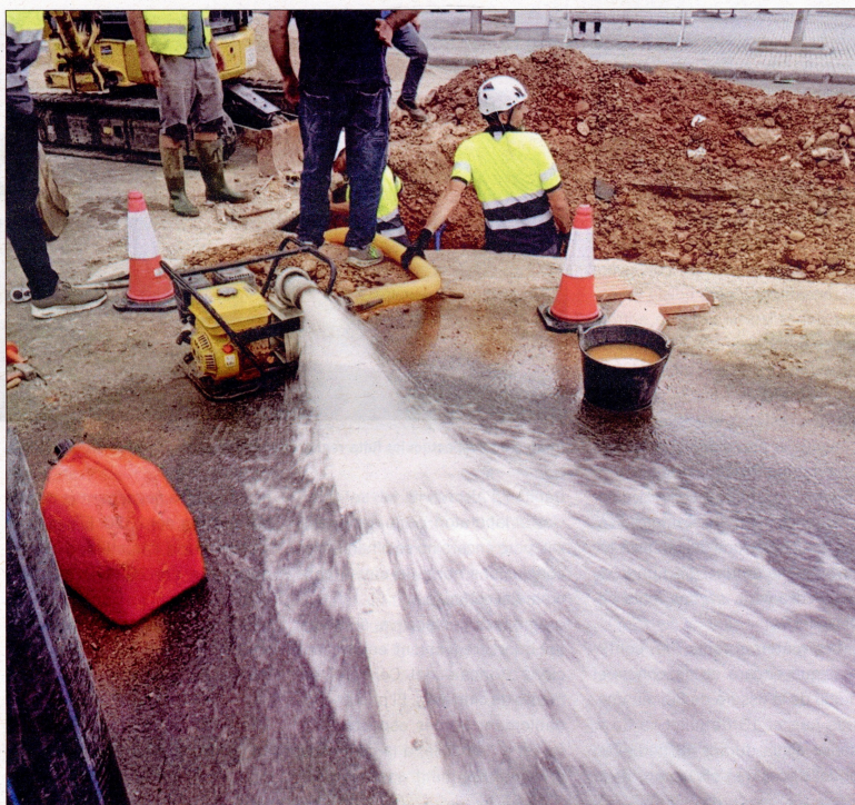
Reparació d'una fuga d'aigua en una canonada de fibrociment a Amposta, registrada al mes de maig. / CEDIDA
