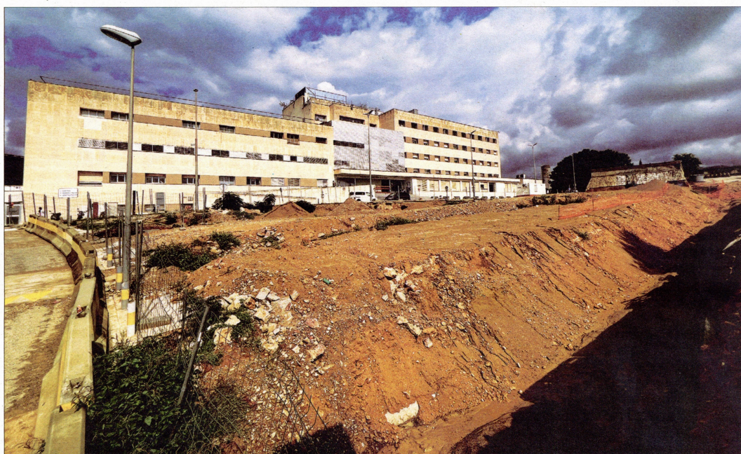
Estat actual de les obres d'ampliació de l'Hospital de Tortosa Verge de la Cinta, que van començar l'any passat. /JOAN JOSEP CAROT
