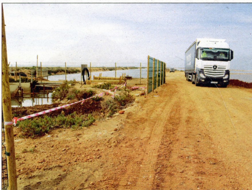
Estat actual de les obres del nou accés a les Salines de la Trinitat. /ACN
