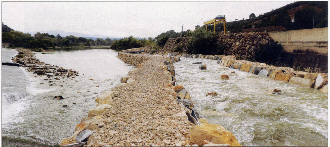
A la dreta, entre margens de pedra, la nova rampa de peixos de l'assut, a la banda de Xerta, entre la hidroelèctrica i la presa.
