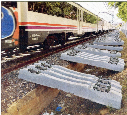
Travesses preparades per a instal·lar ample europeu al corredor mediterrani.
