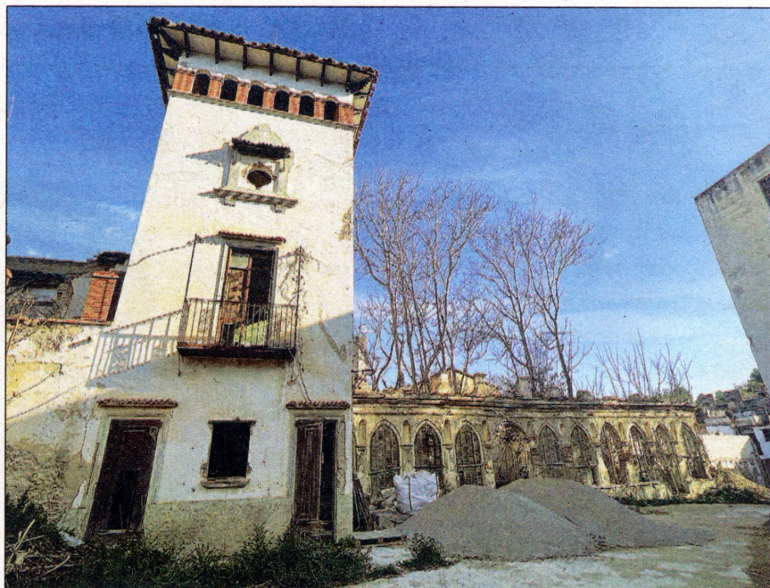
La torre i el pavelló del recinte de l'antic balneari a rehabilitar. /CEDIDA
