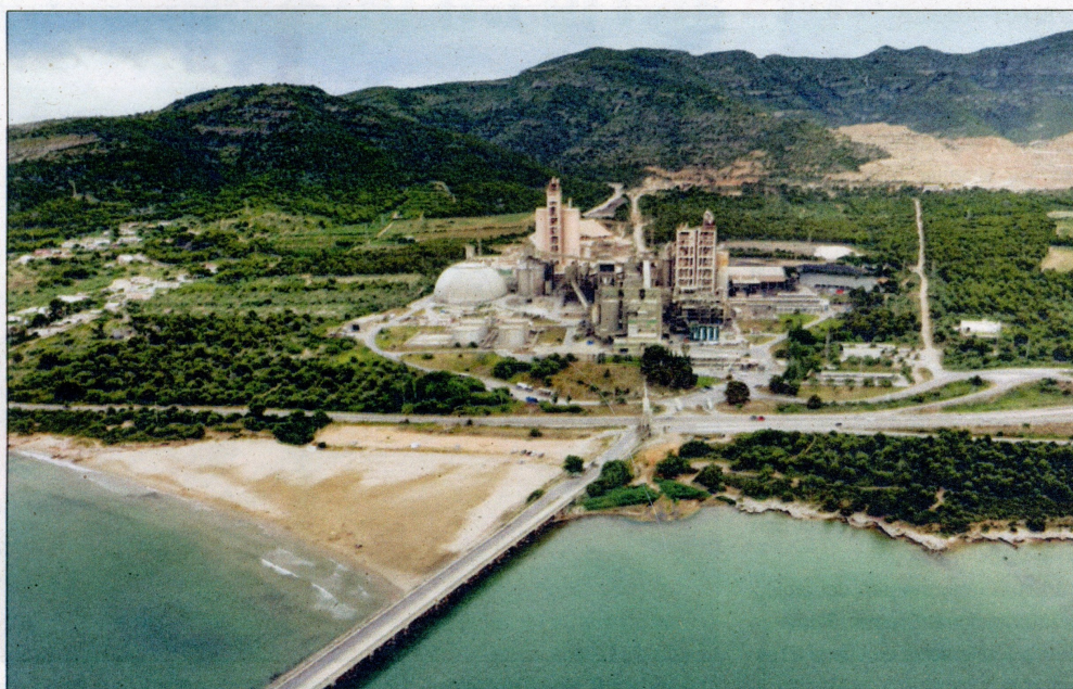
Vista aèria de la planta de fabricació de ciment que té Cemex al litoral del municipi d'Alcanar. / CEDIDA
