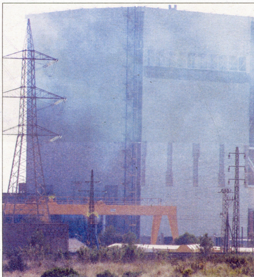
Calaix que guarda el reactor en repòs de Vandellòs I.
