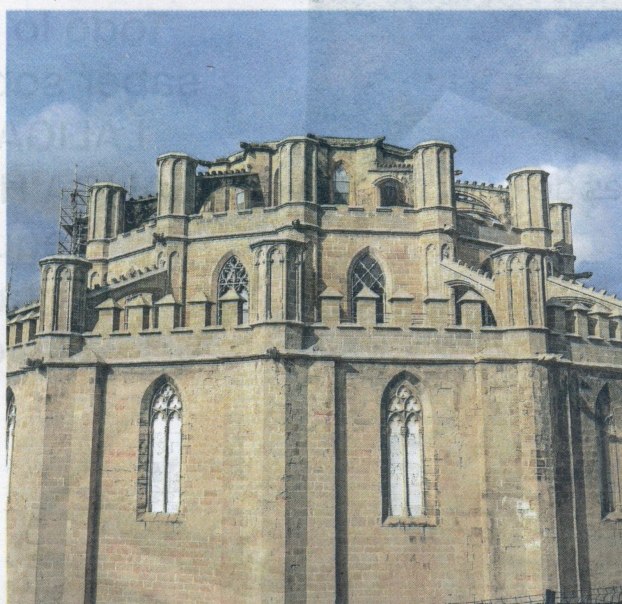
Les obres s'han centrat en el primer nivell de l'Absis. FOTO: J. REVILLAS
