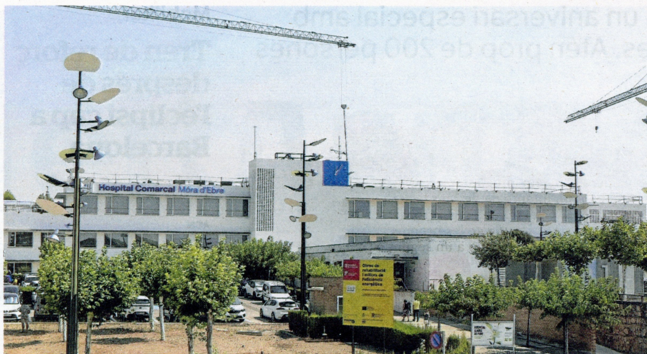
L'Hospital Comarcal de Móra d'Ebre, actualment en obres, fa pocs dies. FOTO: JOAN REVILLAS
