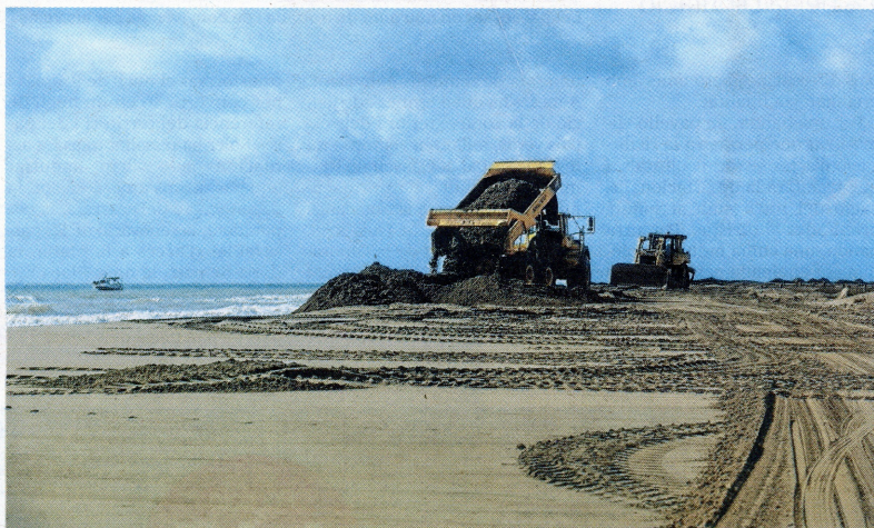
Reposicions de sorres a la barra del Trabucador per enfortir-lo. FOTO: J. REVILLAS
