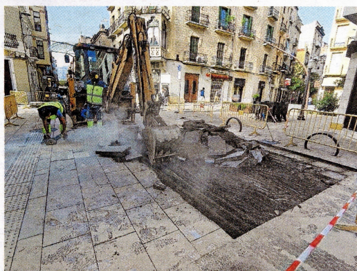
El pas de vehicles havia trencat peces del paviment. FOTO: J. REVILLAS
