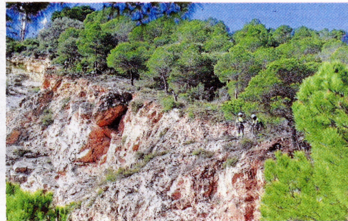
Operaris instal·lant una malla metàl·lica protectora vora la pedrera i l'Institut Els Alfacs. FOTO: J. REVILLAS
