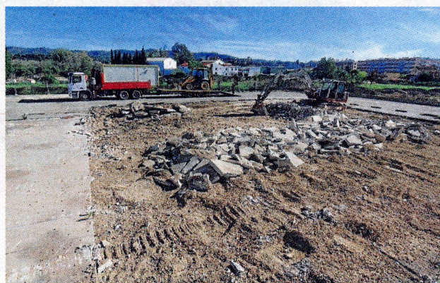
Obres a la futura llar d'infants municipal, vora el centre comercial Alcampo, a Ferreries. FOTO: J. REVILLAS
