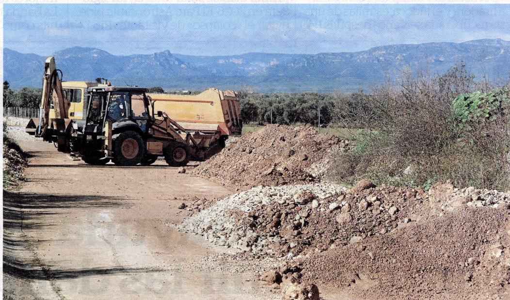
Máquinas excavadoras trabajando ayer por la mañana en reparar los daños de caminos en Els Valentins, Ulldecona. FOTO: J. REVILLAS
