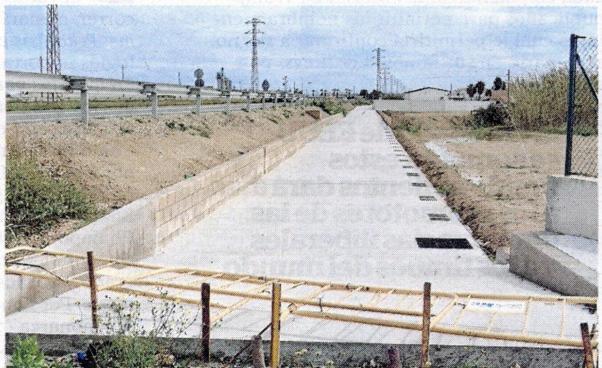
Les obres per construir el futur passeig del Carrilet van començar fa uns mesos. FOTO: J. REVILLAS
