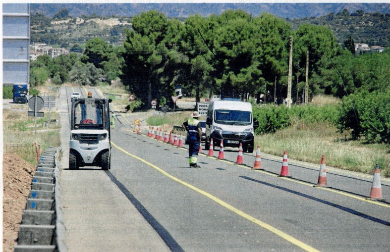
Obres en execució a la C-12 entre Tivissa i Móra la Nova. FOTO: JOAN REVILLAS
