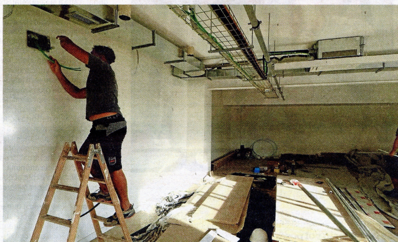
Obres a l'antiga Cambra Arrossera de la Cava, on l'Ajuntament hi està treballant. FOTO: J. REVILLAS
