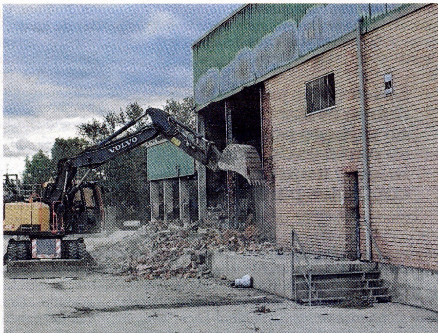
Una màquina excavadora treballant en l'enderroc, ahir a la tarda.
