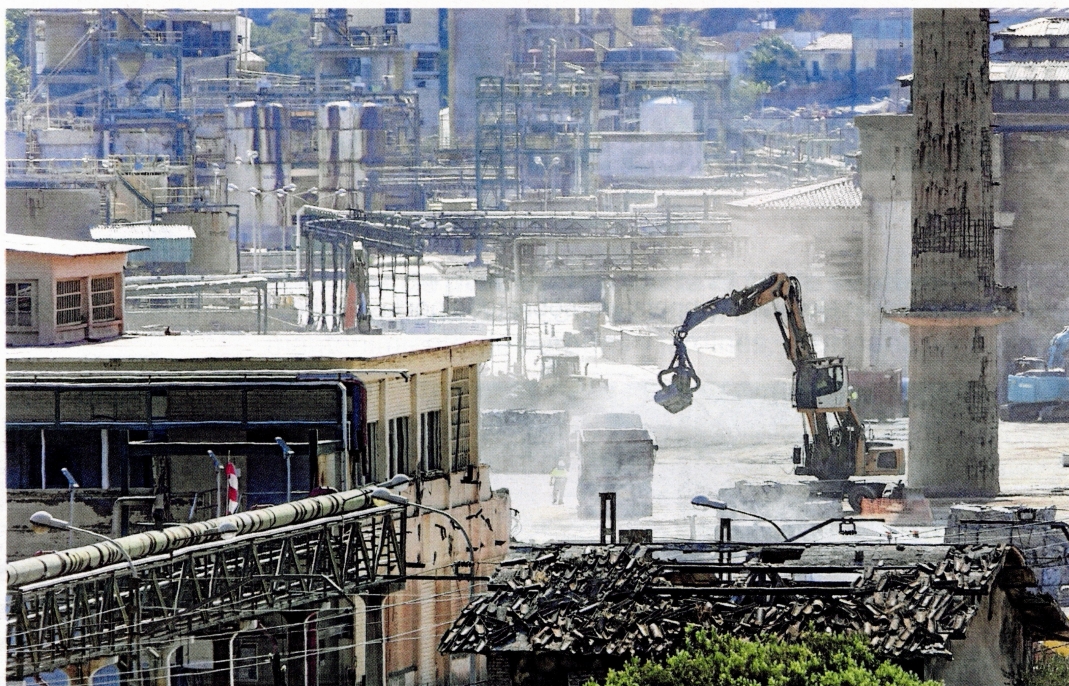
Trabajos de demolición, esta semana, de la antigua nave de Acuamed en el complejo industrial de Ercros en Flix. FOTO: JOAN REVILLAS
