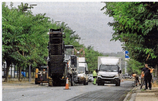
Treballs d'asfaltatge al polígon entre Tortosa i Roquetes, aquesta setmana. FOTO: J. REVILLAS
