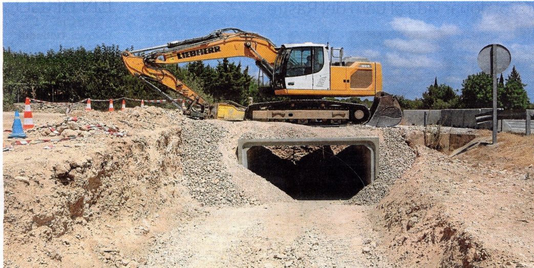
Obres al barranc del Llop d'Alcanar Platja, que ajudaran a distribuir l'aigua i evitar danys en una urbanització. FOTO: ACN
