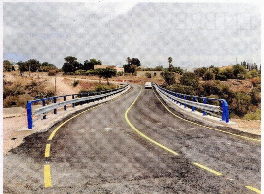
Les obres finalitzaran durant el mes de novembre. FOTO: DIPUTACIÓ TGN
