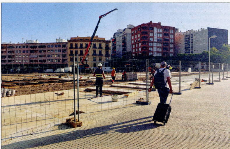
Estat actual de les obres del nou aparcament que executa l'empresa Also Casals als terrenys d'Adif. /C. PUIG
