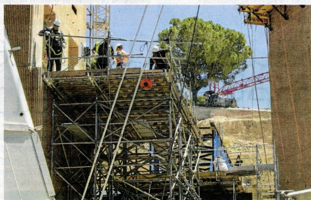
Els treballs han requerit un important dispositiu i maquinària pesant. FOTO: JOAN REVILLAS
