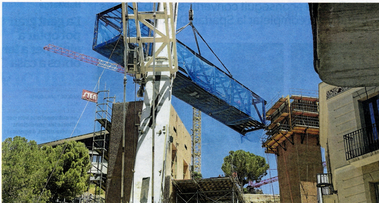
Operatiu per instal·lar una de les passarel·les. FOTO: JOAN REVILLAS
