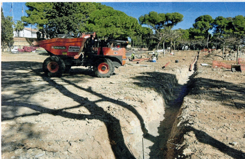
Imatge d'arxiu d'obres al Càmping Alfacs, empresa beneficiària d'ajuts Leader. FOTO: JOAN REVILLAS
