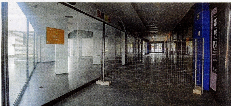
Estat de les galeries del centre comercial. FOTO: JOAN REVILLAS
