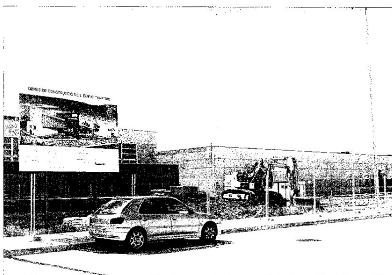
Obres de construcció del nou tanatori, a la zona dels Portals de Ciutat. FOTO: JOAN RIVILLAS
