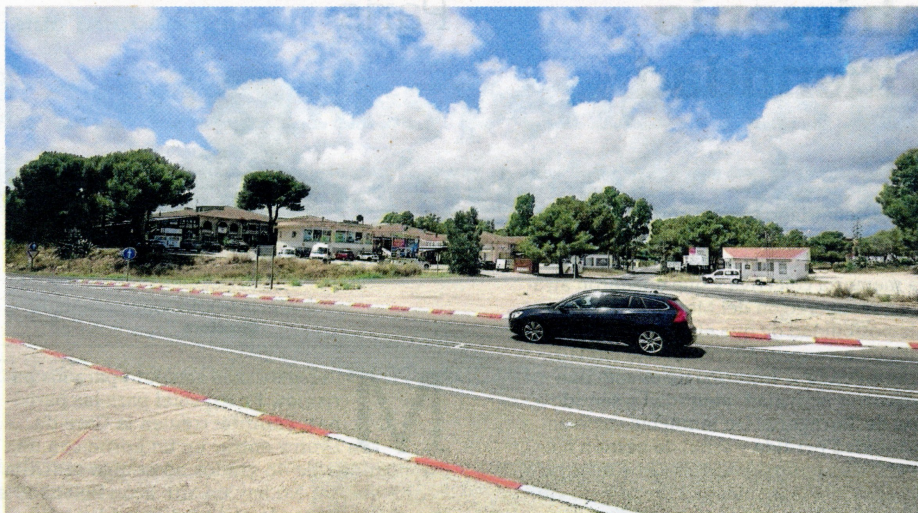
Accés a la urbanització Tres Cales de l'Ametlla de Mar. FOTO: JOAN REVILLAS
